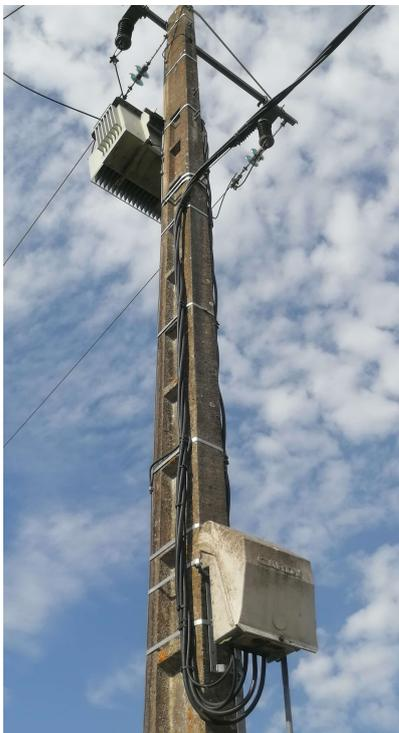
En raison d'une surcharge sur le poste de type H61 qui affichait un taux de charge de 129,26% sur un transformateur de 100 kVA, un nouveau poste de type PSSA a été implanté permettant ainsi de passer à un transformateur de 160 kVA et réduisant la charge à 84,22%.
